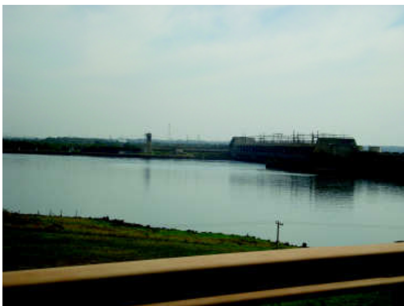
Figura 06 – Vista da UHE Engenheiro Souza Dias (Foto: Ivan de Sousa Soares).
